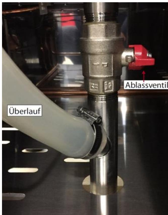
Unterlegen Sie ein Gefäss, auch wegen dem Überlauf. Dieses Wasser fliesst frei aus. Verfügen Sie über einen Bodenablauf ist dies unnötig.
